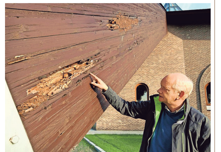
De grote verrottingsplek in een van de houten spanten. Bogaerts
